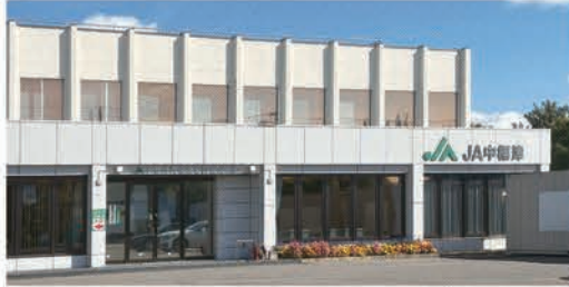
裏には新事務所の建設も進むJA中標津事務所
