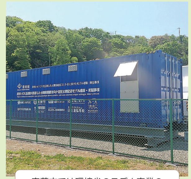
室蘭市では環境省のモデル事業の一環で、既存のLPガスの配送インフラを利用して、家庭や小規模な事業所などに水素を届ける実証実験が行われている。
