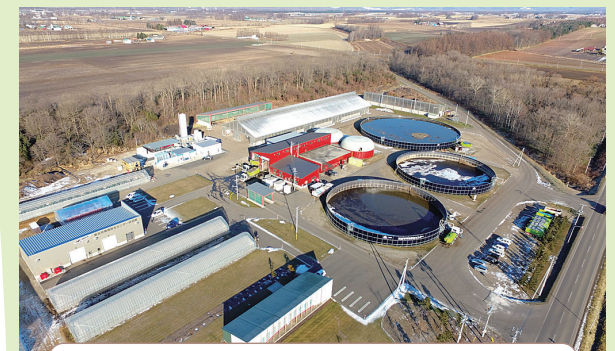
鹿追町の脱炭素の核となる町中鹿追のバイオマスプラント(町環境保全センター)。水素製造プラント、水素ステーションを備えている。LPガスの製造実証試験も計画されている。(写真:鹿追町)
