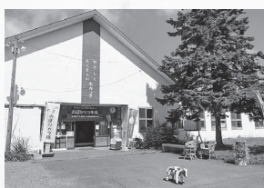
赤い三角屋根の建物が印象的な工場・直売所
